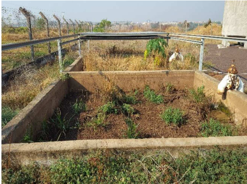
Figura 07: Leito de secagem.
