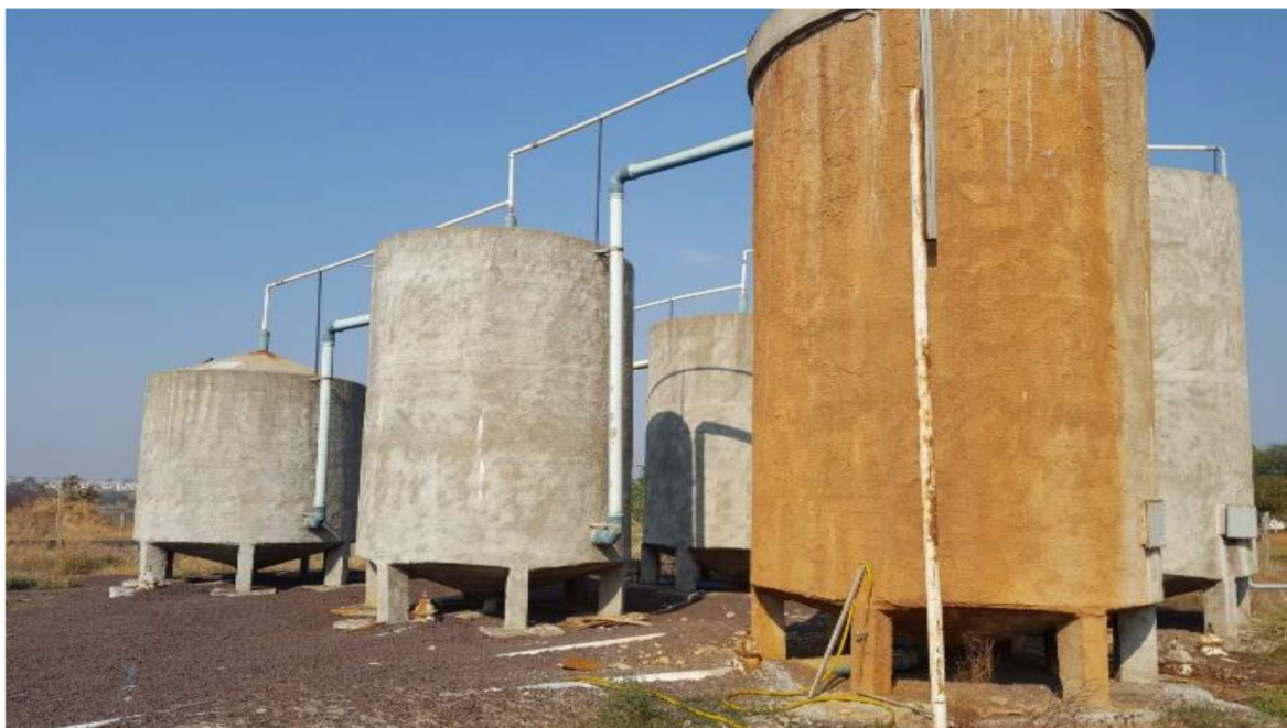
Figura 06: Câmara de contato de fluxo hidráulico horizontal para desinfecção.
