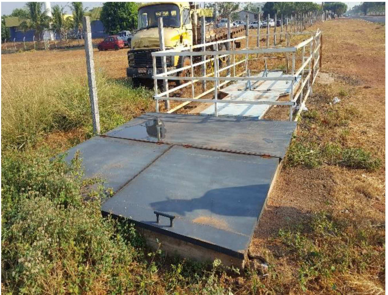
Figura 04: Tratamento preliminar composto de gradeamento e desarenador.
