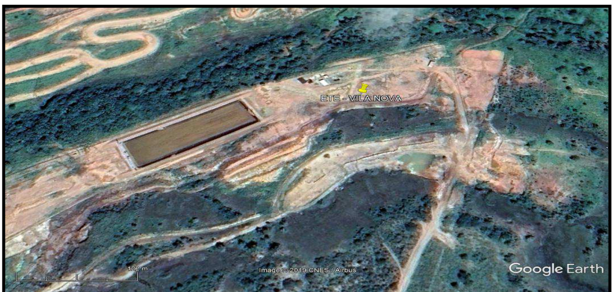
Figura 08: Vista da Área de Implantação da Nova ETE.
